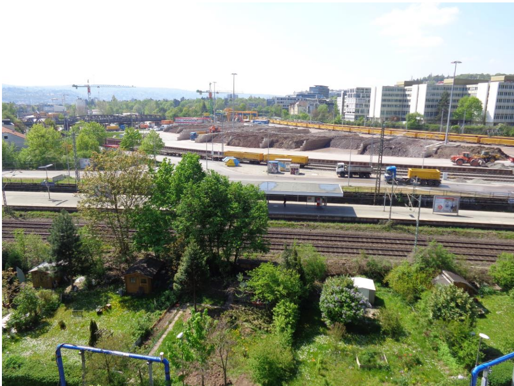
Abbildung 1: Blick auf das Baufeld bei Messbeginn am 02.05.2016
