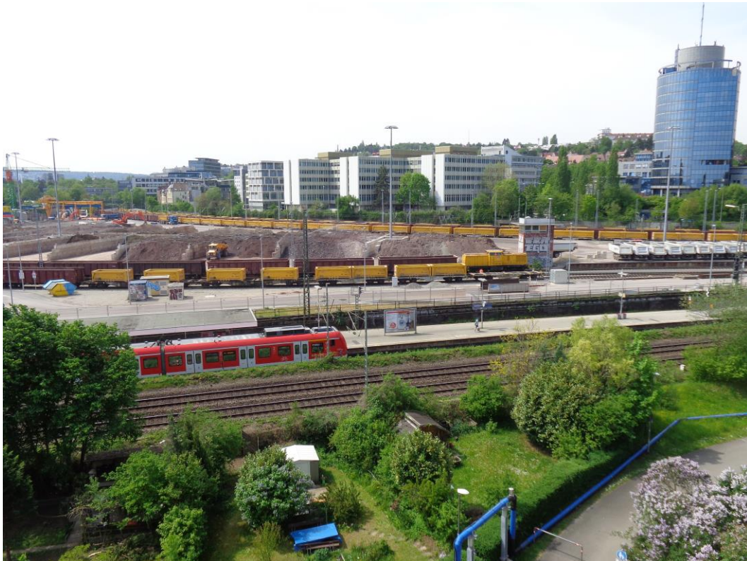
Abbildung 2: Blick auf das Baufeld bei Messende am 09.05.2016
