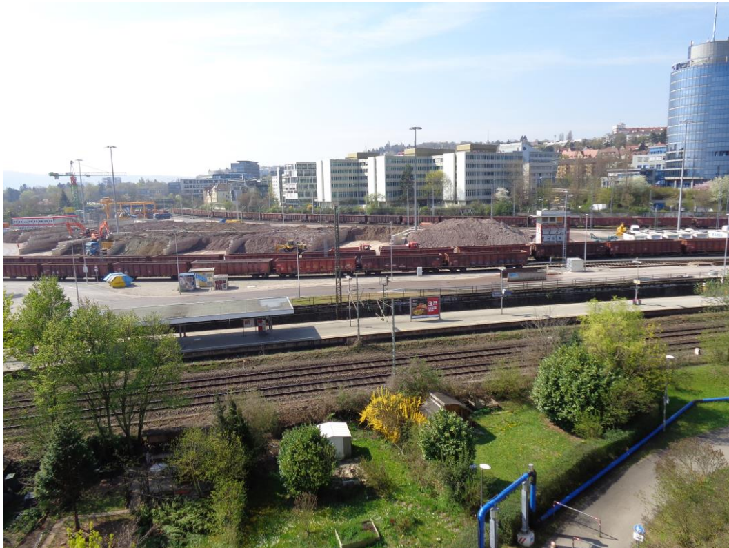
Abbildung 2: Blick auf das Baufeld bei Messende am 11.04.2016
