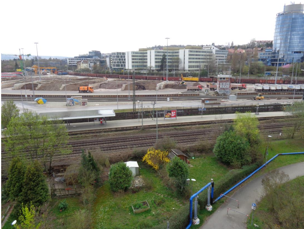
Abbildung 1: Blick auf das Baufeld bei Messbeginn am 04.04.2016
