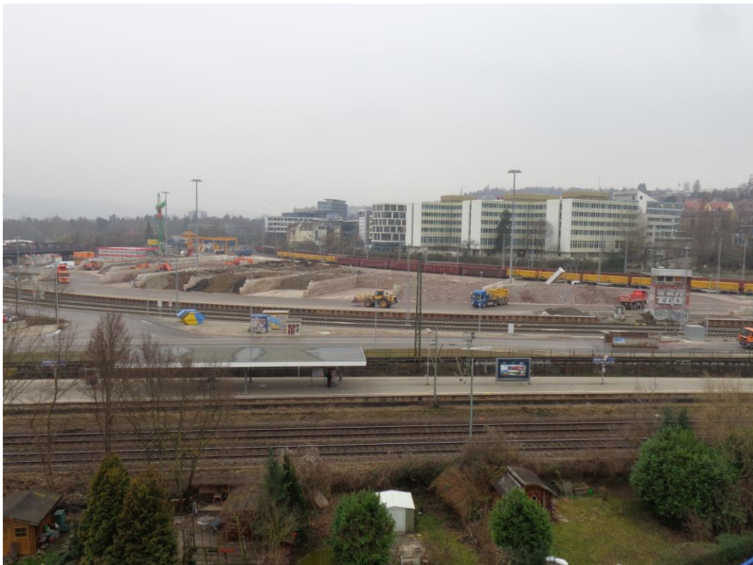
Abbildung 1: Blick auf das Baufeld bei Messbeginn am 29.02.2016
