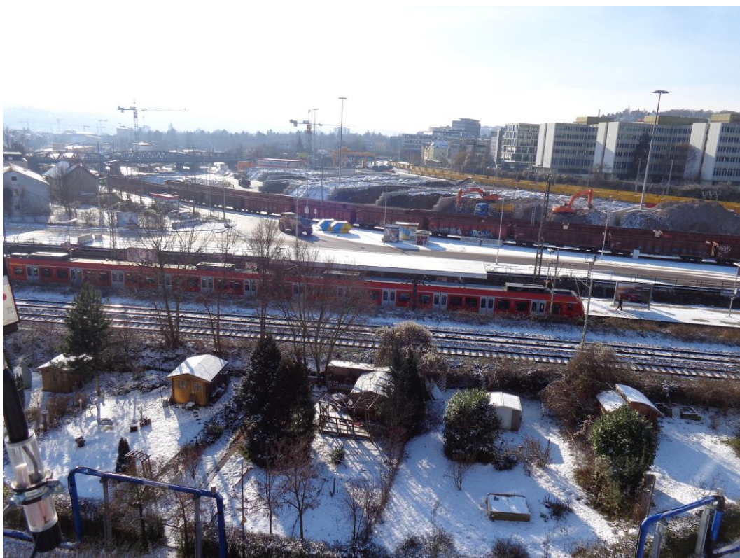
Abbildung 1: Blick auf das Baufeld bei Messbeginn am 18.01.2016
