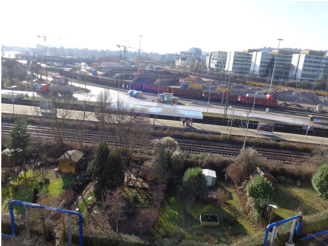
Abbildung 2: Blick auf das Baufeld bei Messende am 25.01.2016
