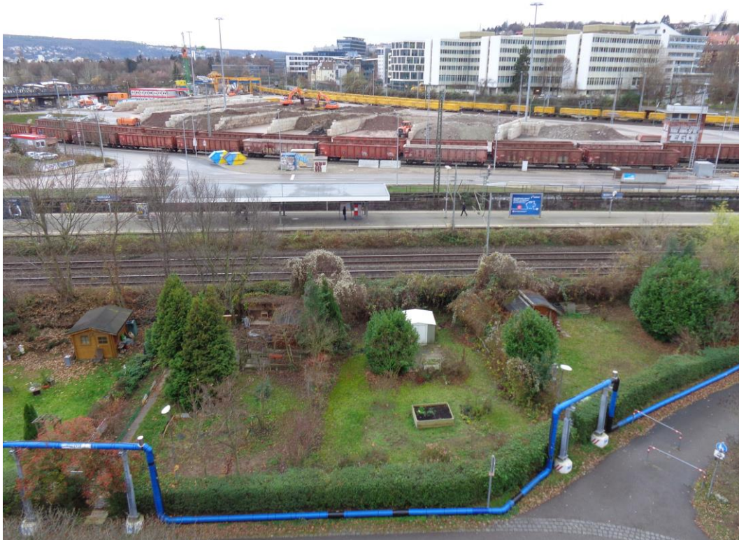
Abbildung 2: Blick auf das Baufeld bei Messende am 30.11.2015
