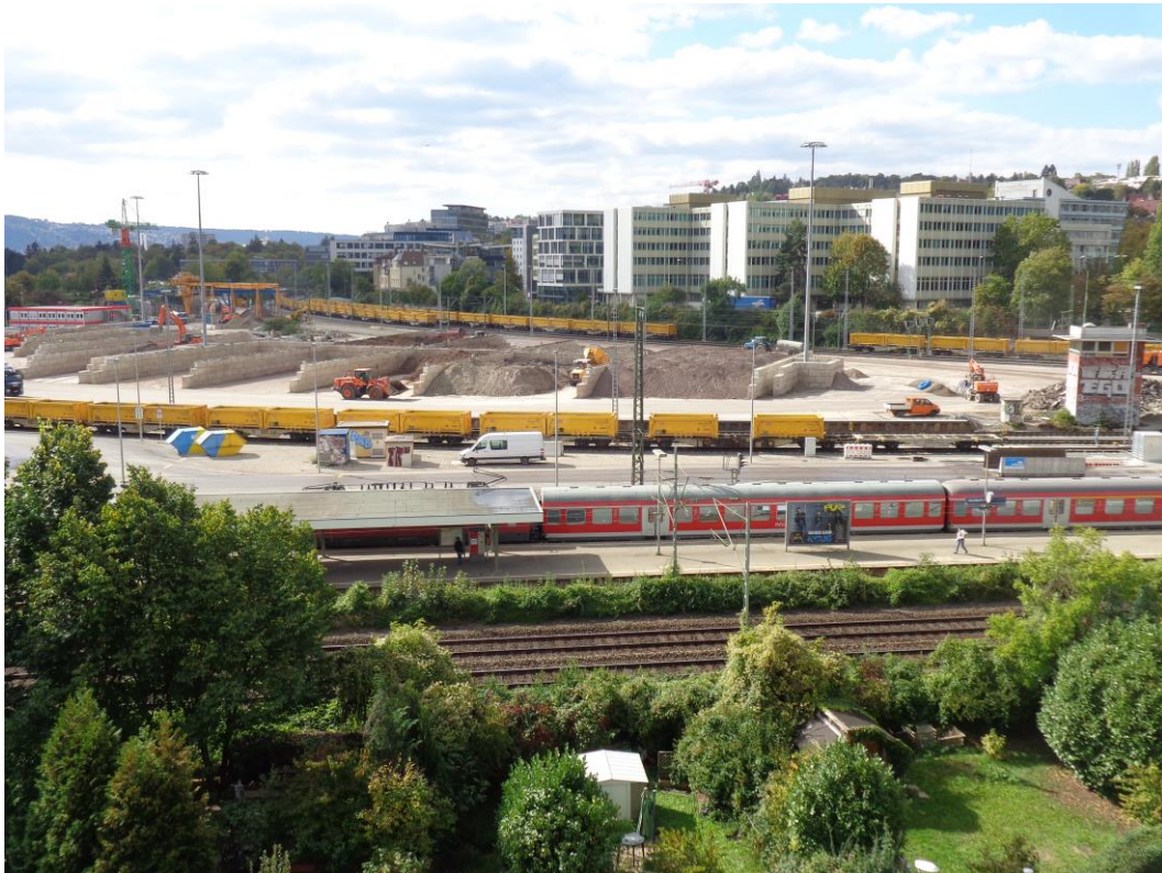
Abbildung 2: Blick auf das Baufeld bei Messende am 28.09.2015
