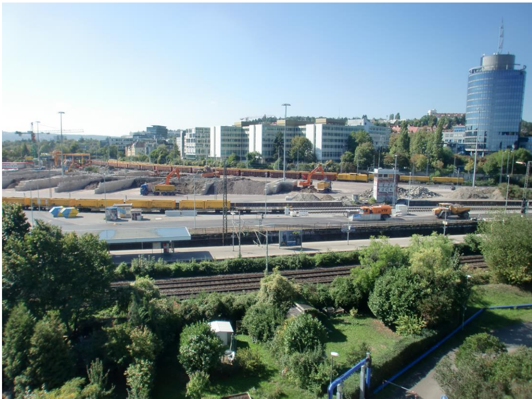
Abbildung 1: Blick auf das Baufeld bei Messbeginn am 21.09.2015
