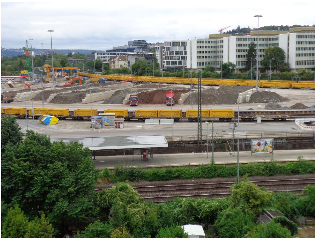
Abbildung 1: Blick auf das Baufeld bei Messbeginn am 17.08.2015
