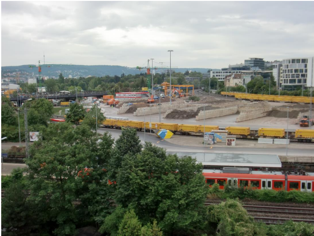
Abbildung 2: Blick auf das Baufeld bei Messende am 24.08.2015
