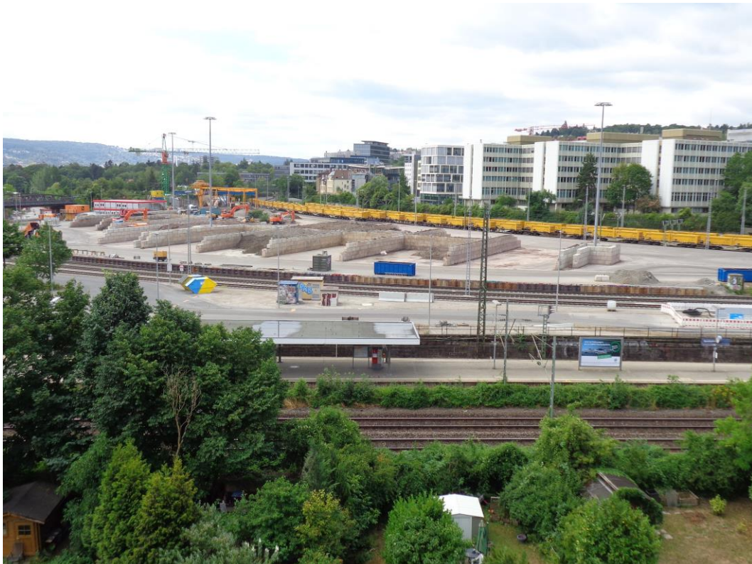
Abbildung 2: Blick auf das Baufeld bei Messende am 20.07.2015
