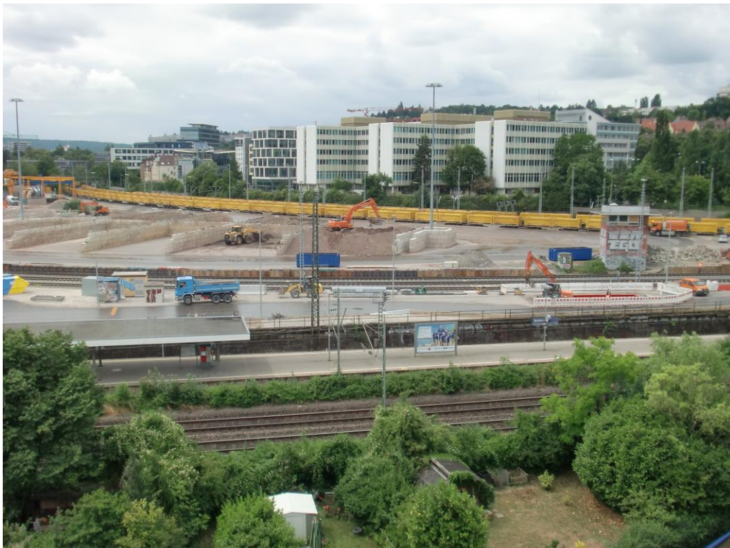
Abbildung 1: Blick auf das Baufeld bei Messbeginn am 13.07.2015
