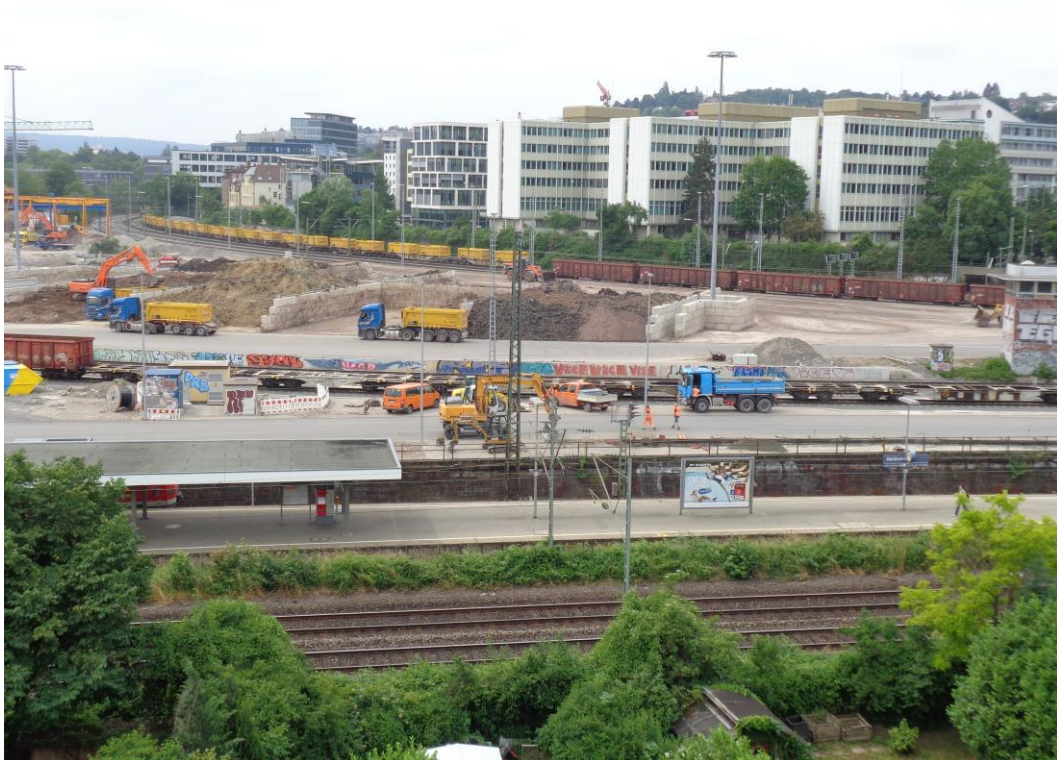
Abbildung 1: Blick auf das Baufeld bei Messbeginn am 15.06.2015
