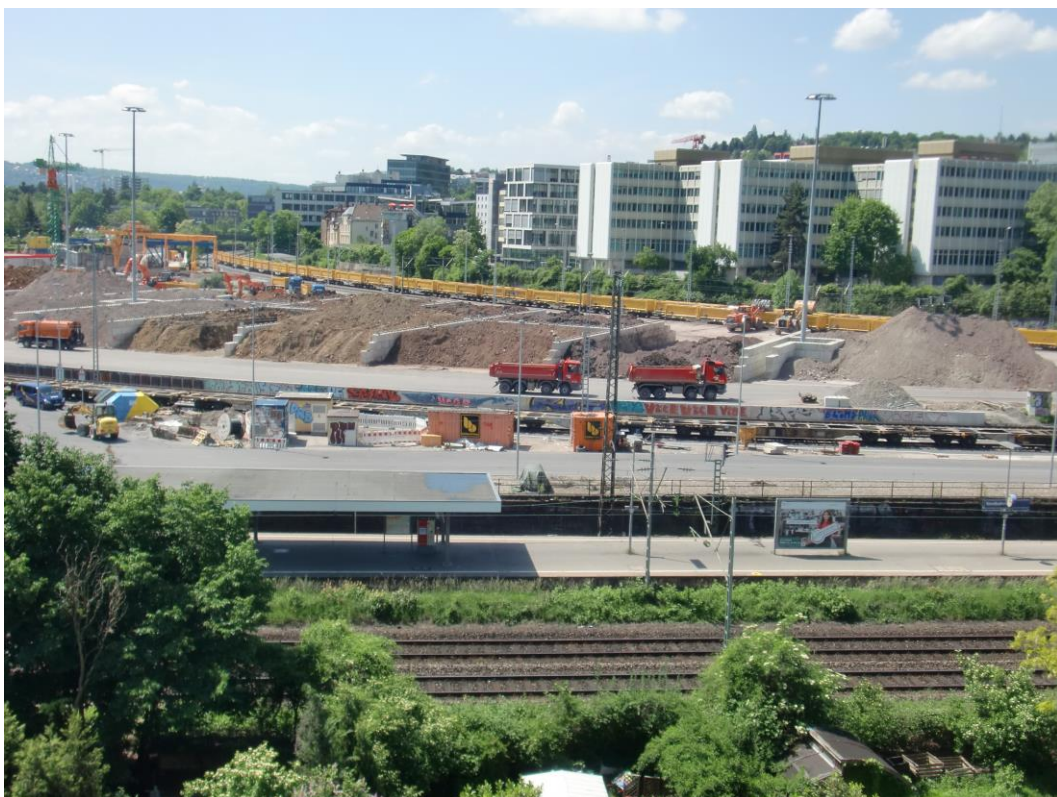
Abbildung 1: Blick auf das Baufeld bei Messbeginn am 18.05.2015
