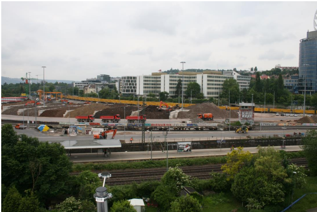
Abbildung 2: Blick auf das Baufeld bei Messende am 26.05.2015
