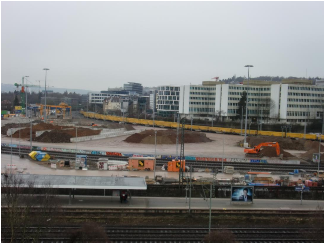
Abbildung 2: Blick auf das Baufeld bei Messende am 23.02.2015
