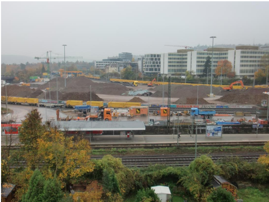
Abbildung 1: Blick auf das Baufeld bei Messbeginn am 10.11.2014
