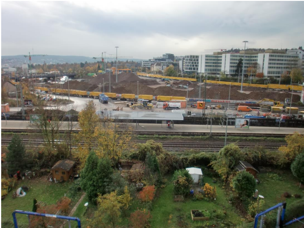
Abbildung 2: Blick auf das Baufeld bei Messende am 17.11.2014
