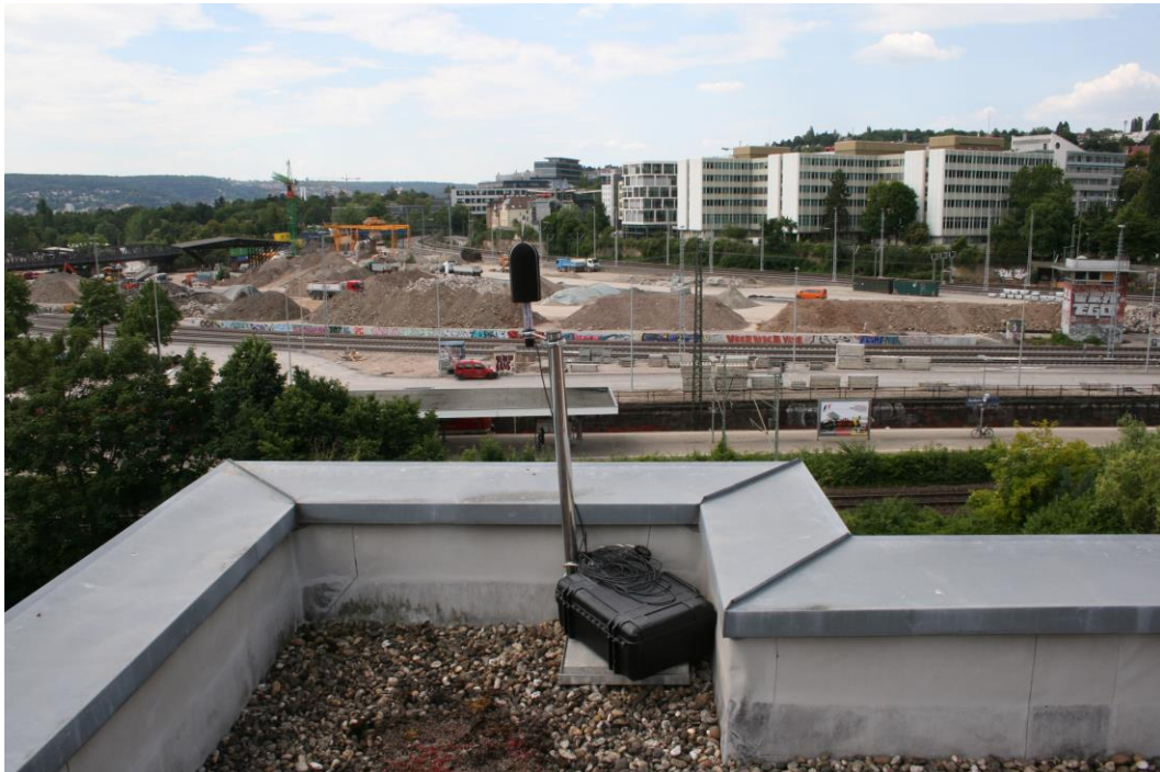
Abbildung 1: Messposition auf dem Dach mit Blick auf die C2-Fläche
