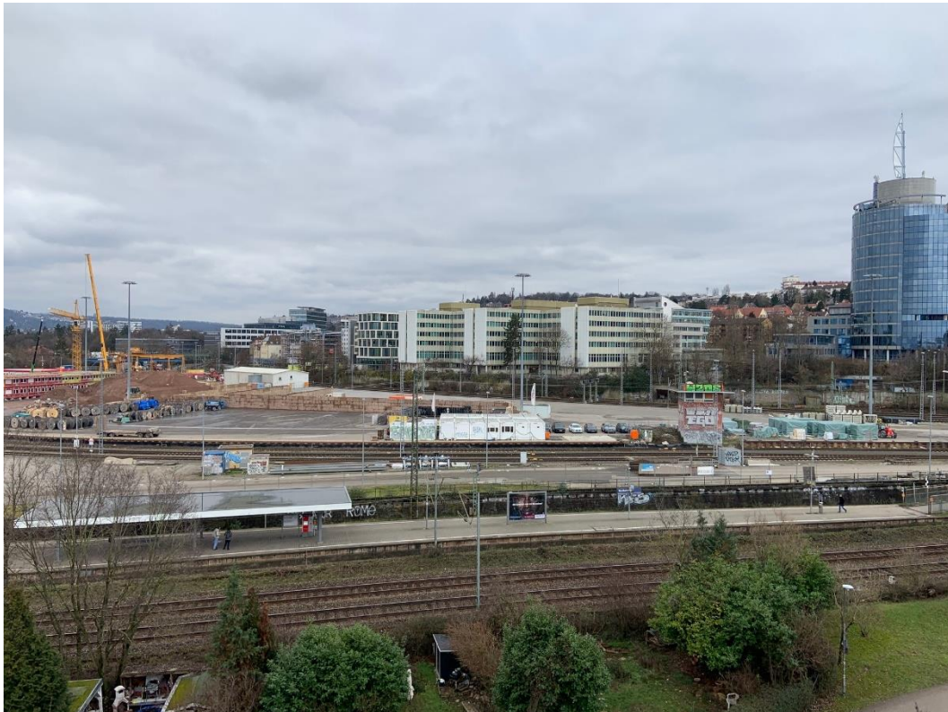
Abbildung 2: Blick auf das Baufeld bei Messende am 06.02.2023
