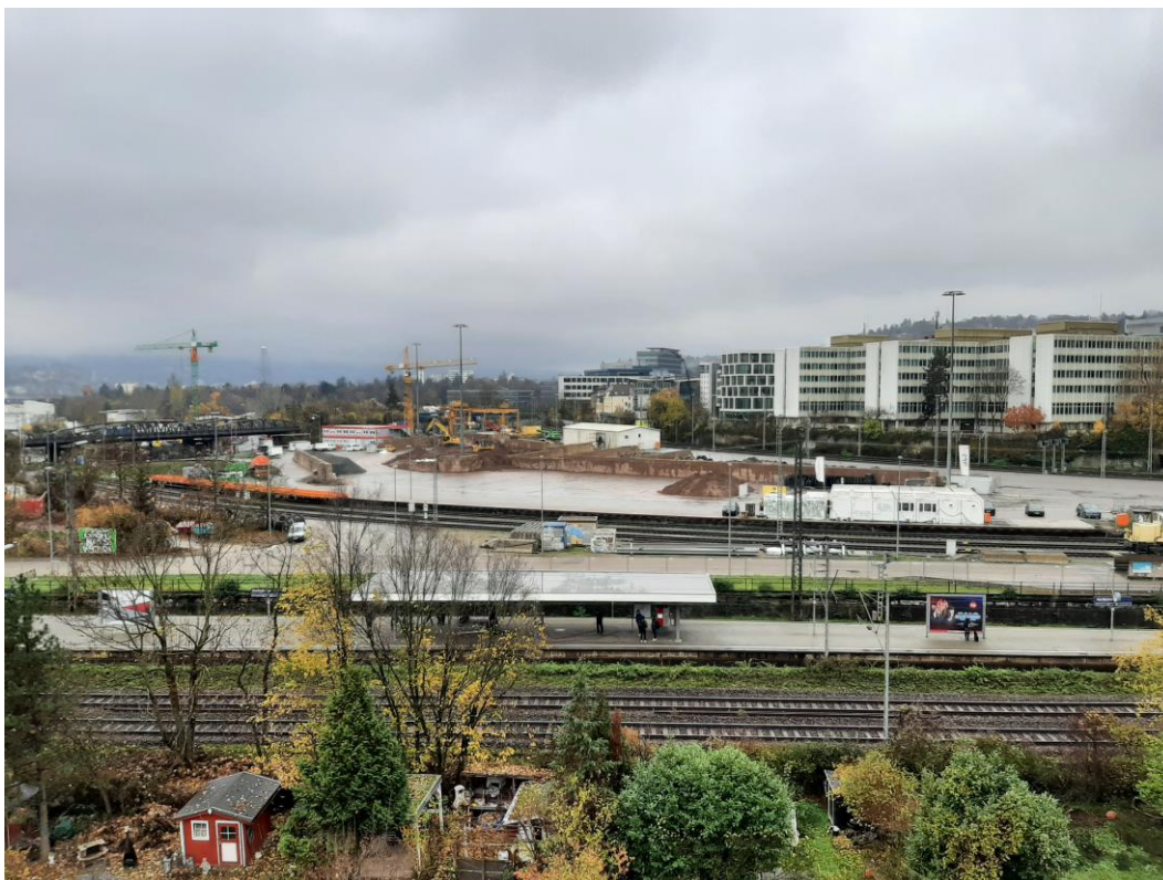
Abbildung 2: Blick auf das Baufeld bei Messende am 28.11.2022
