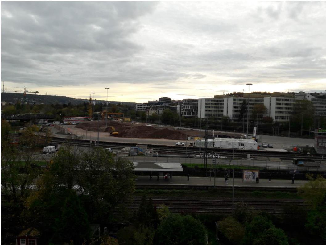
Abbildung 2: Blick auf das Baufeld bei Messende am 07.11.2022
