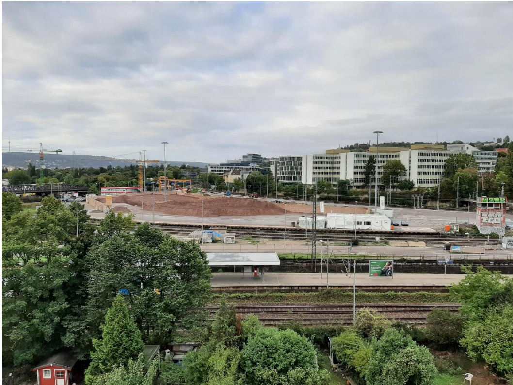
Abbildung 2: Blick auf das Baufeld bei Messende am 19.09.2022
