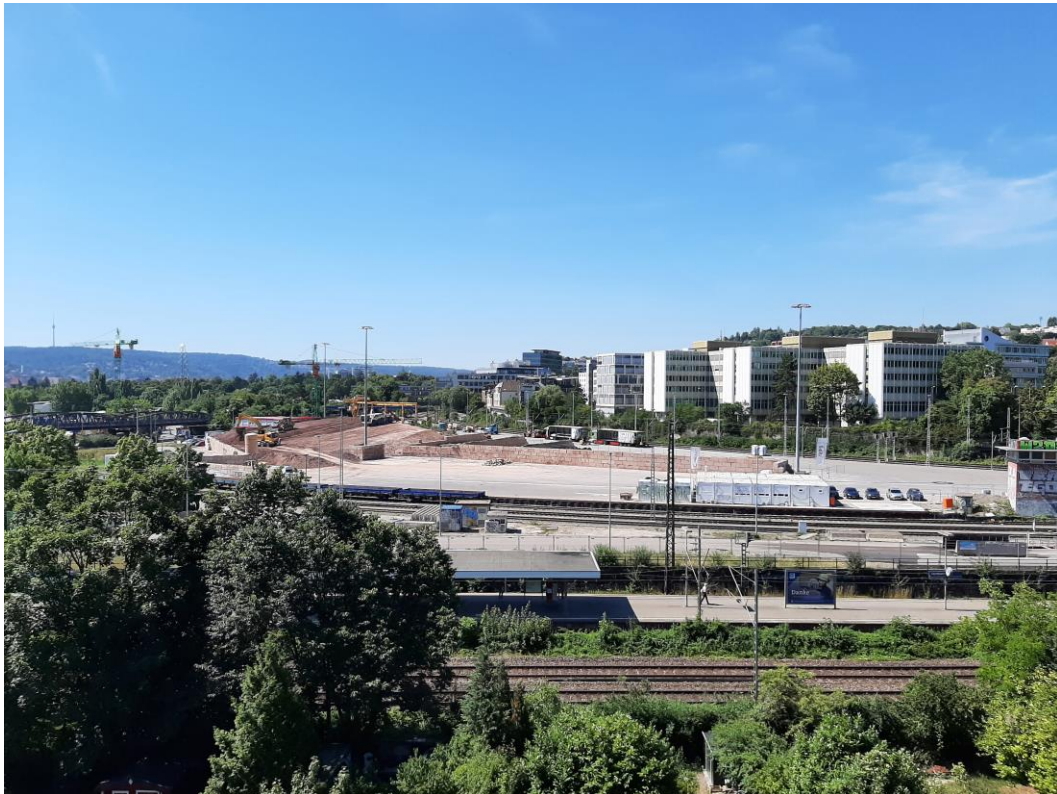
Abbildung 2: Blick auf das Baufeld bei Messende am 18.07.2022
