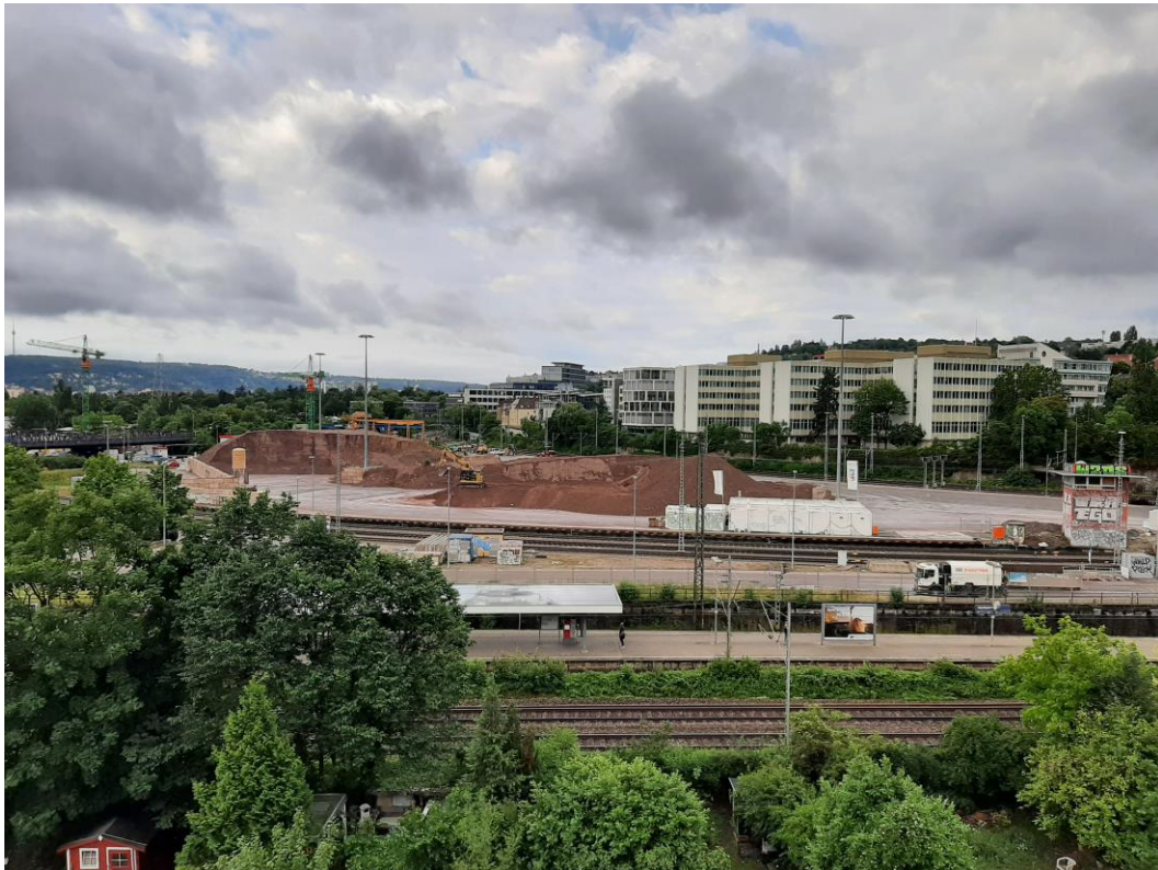
Abbildung 2: Blick auf das Baufeld bei Messende am 27.06.2022
