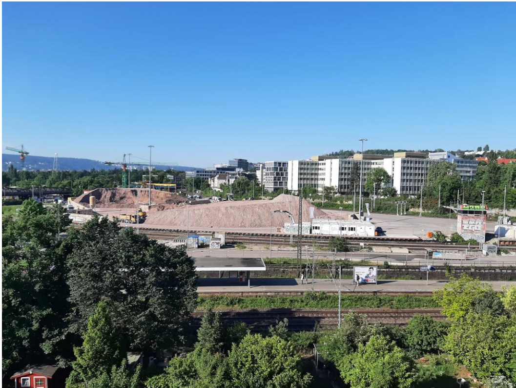
Abbildung 2: Blick auf das Baufeld bei Messende am 30.05.2022
