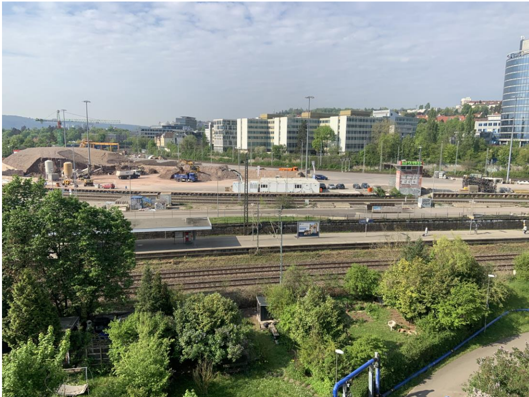
Abbildung 2: Blick auf das Baufeld bei Messende am 02.05.2022
