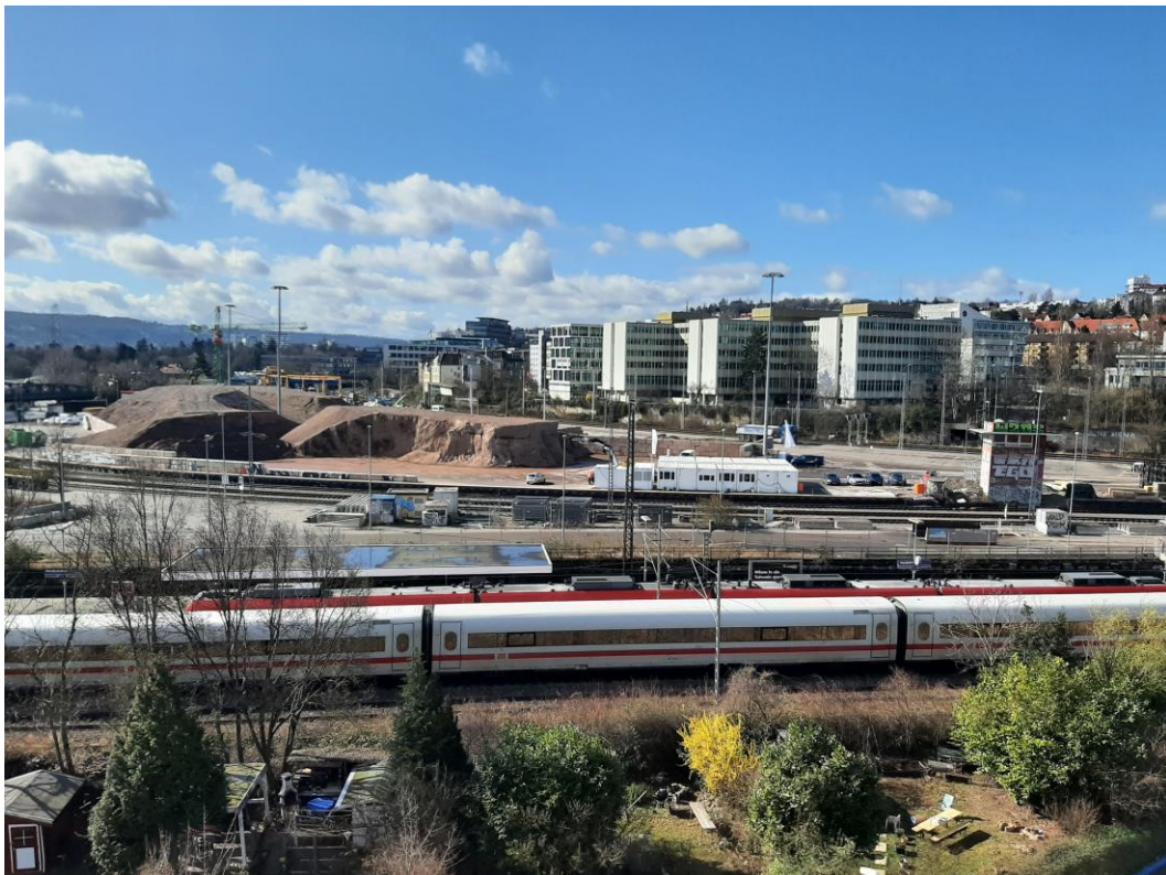
Abbildung 2: Blick auf das Baufeld bei Messende am 14.03.2022
