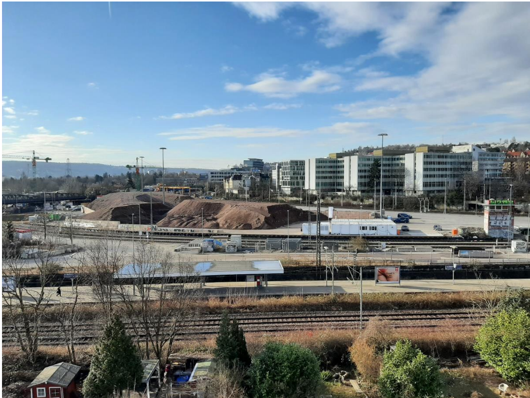
Abbildung 2: Blick auf das Baufeld bei Messende am 14.02.2022
