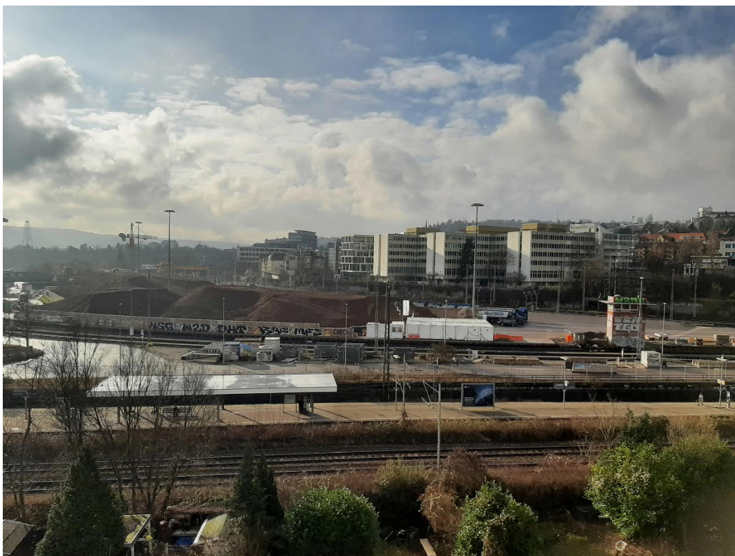
Abbildung 1: Blick auf das Baufeld bei Messende am 13.12.2021
