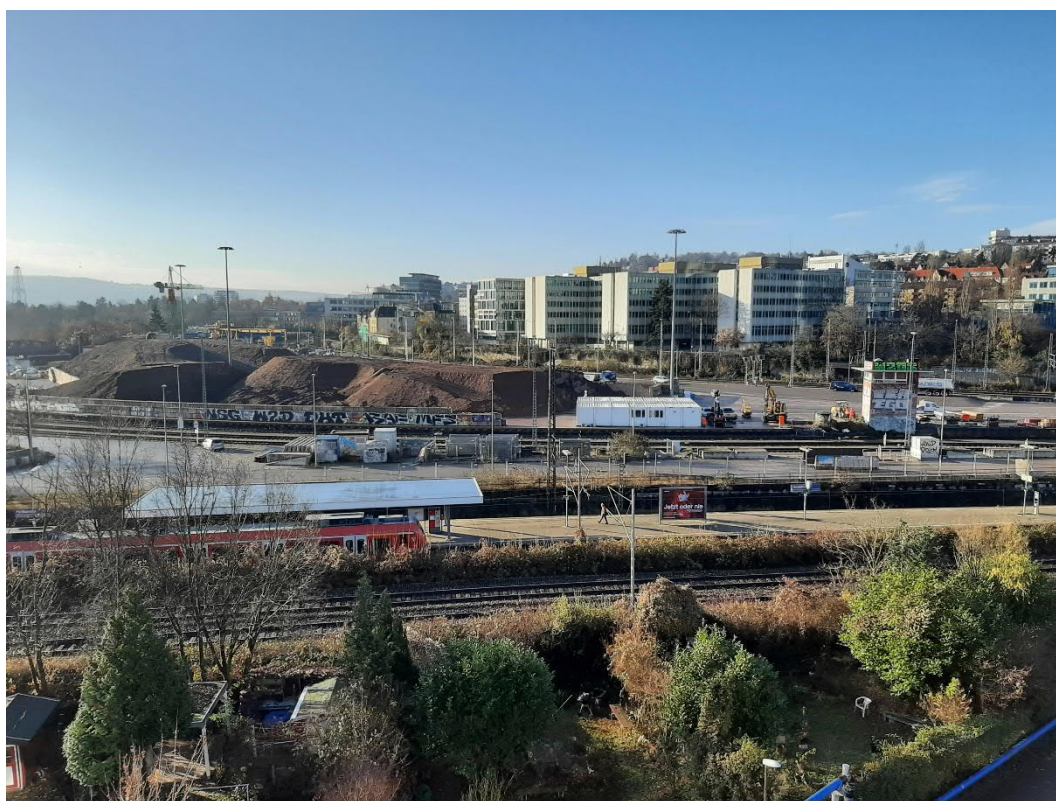
Abbildung 1: Blick auf das Baufeld bei Messbeginn am 29.11.2021
