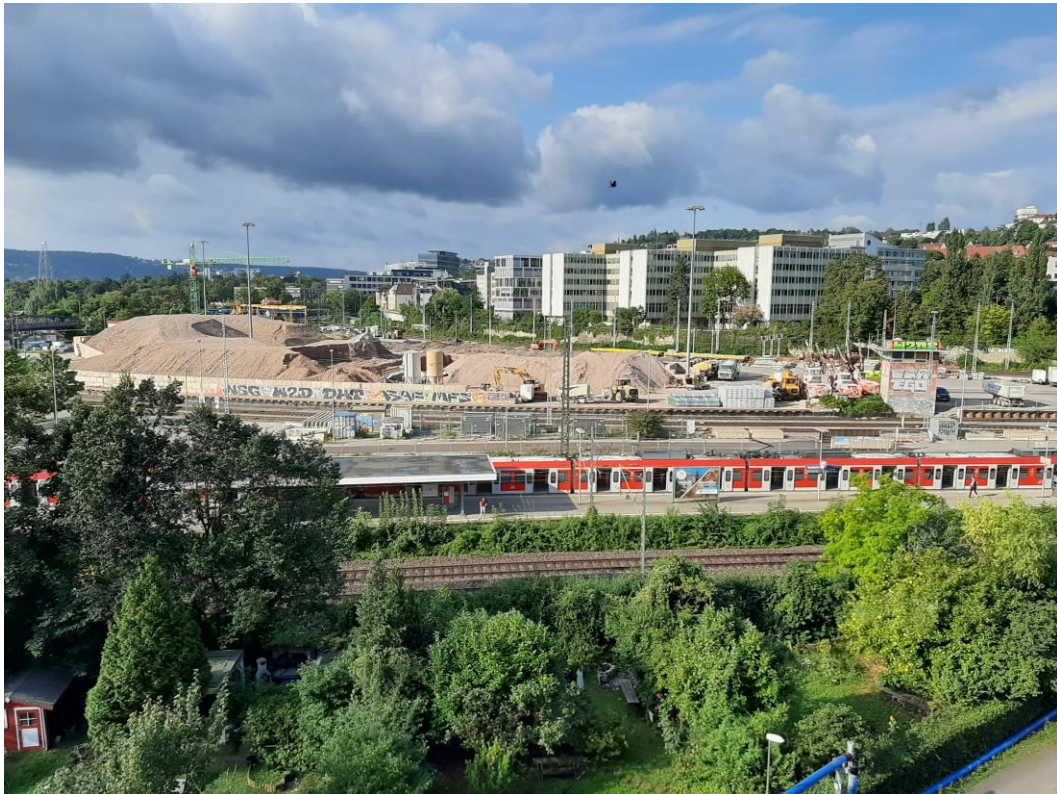
Abbildung 2: Blick auf das Baufeld bei Messende am 16.08.2021
