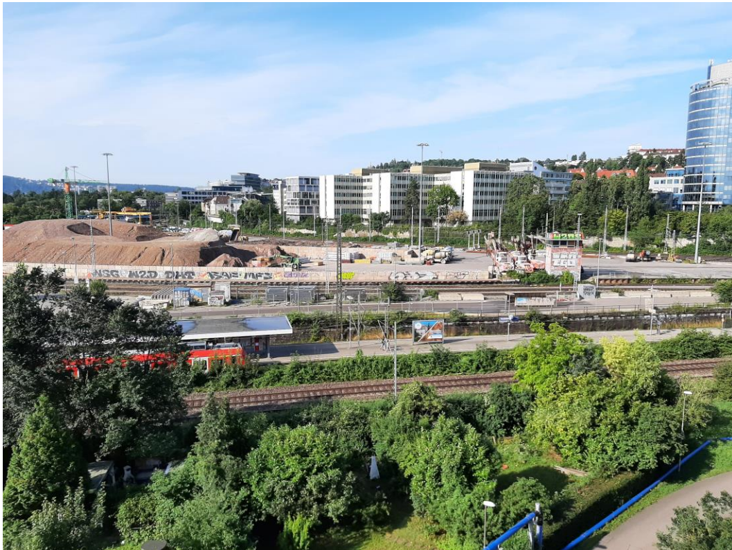
Abbildung 2: Blick auf das Baufeld bei Messende am 26.07.2021
