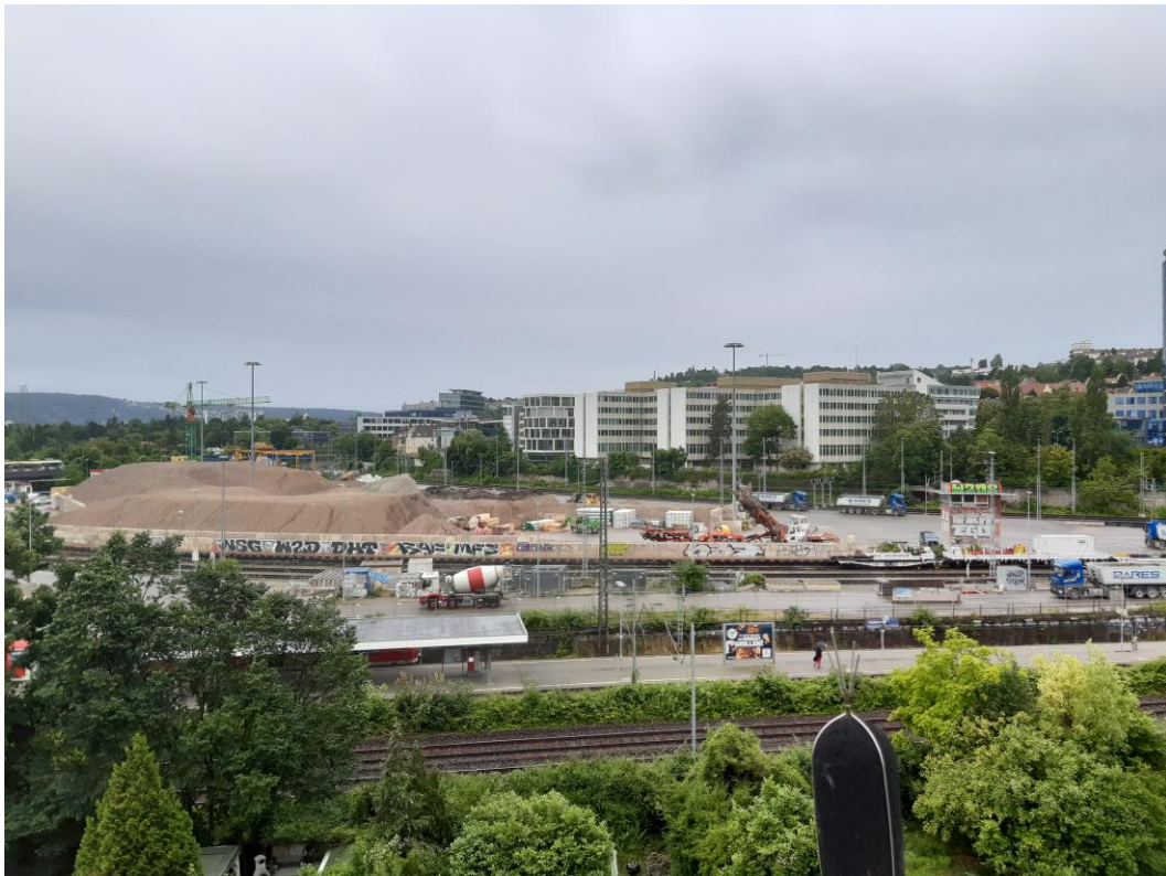
Abbildung 2: Blick auf das Baufeld bei Messende am 05.07.2021
