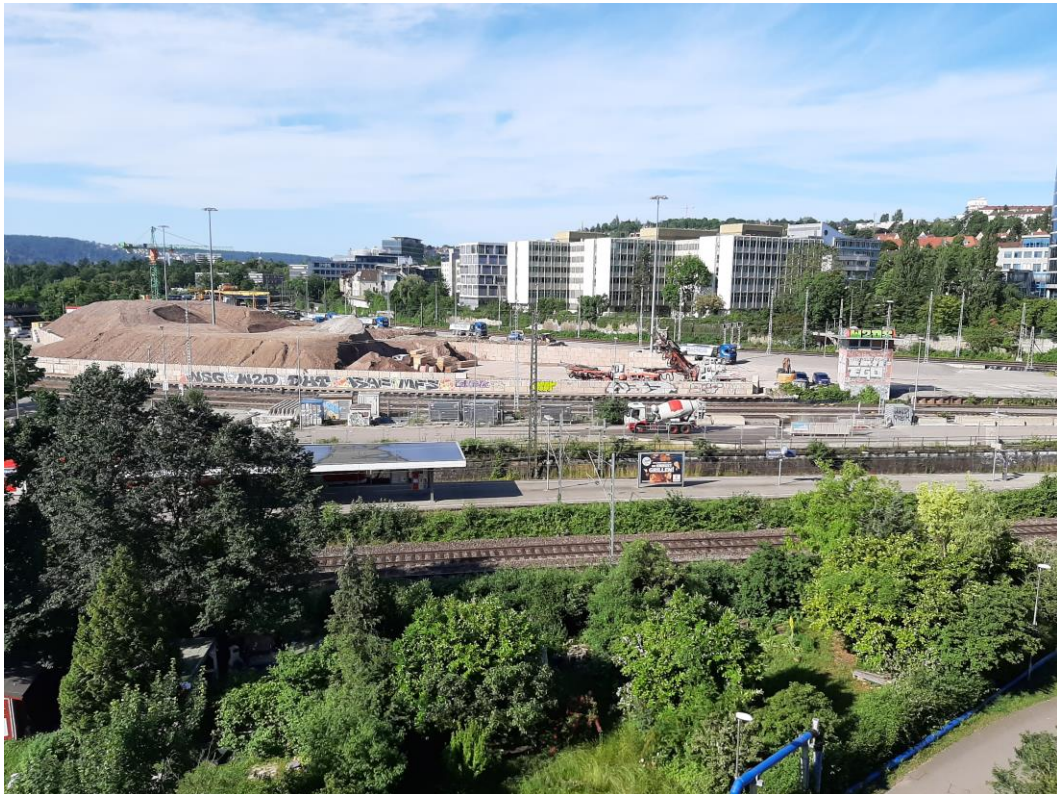
Abbildung 2: Blick auf das Baufeld bei Messende am 21.06.2021
