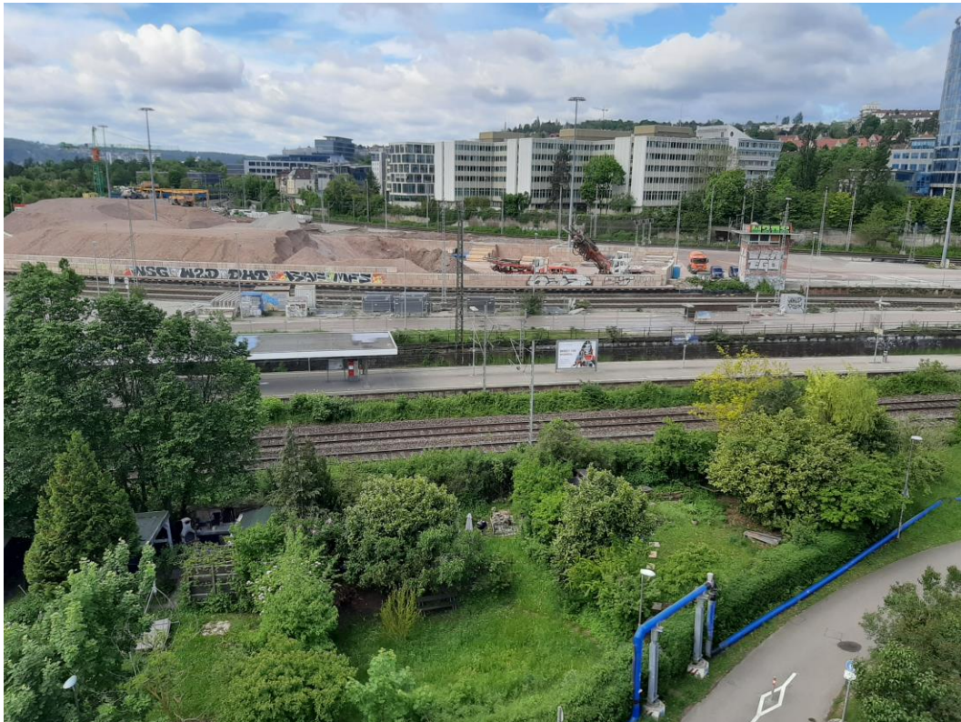
Abbildung 2: Blick auf das Baufeld bei Messende am 24.05.2021
