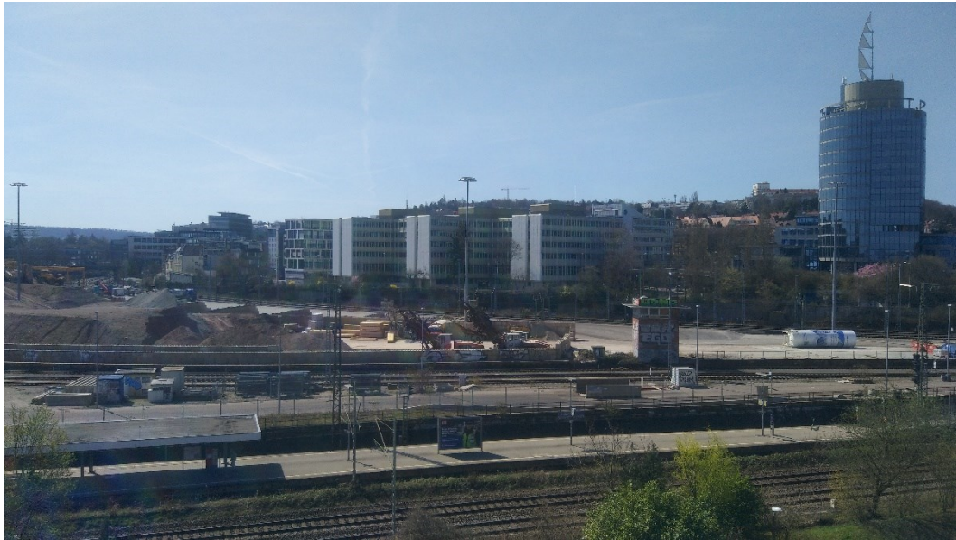
Abbildung 2: Blick auf das Baufeld bei Messende am 29.03.2021
