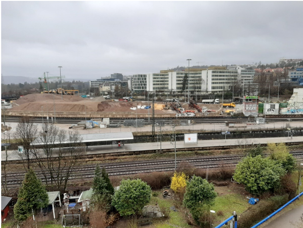
Abbildung 2: Blick auf das Baufeld bei Messende am 15.03.2021
