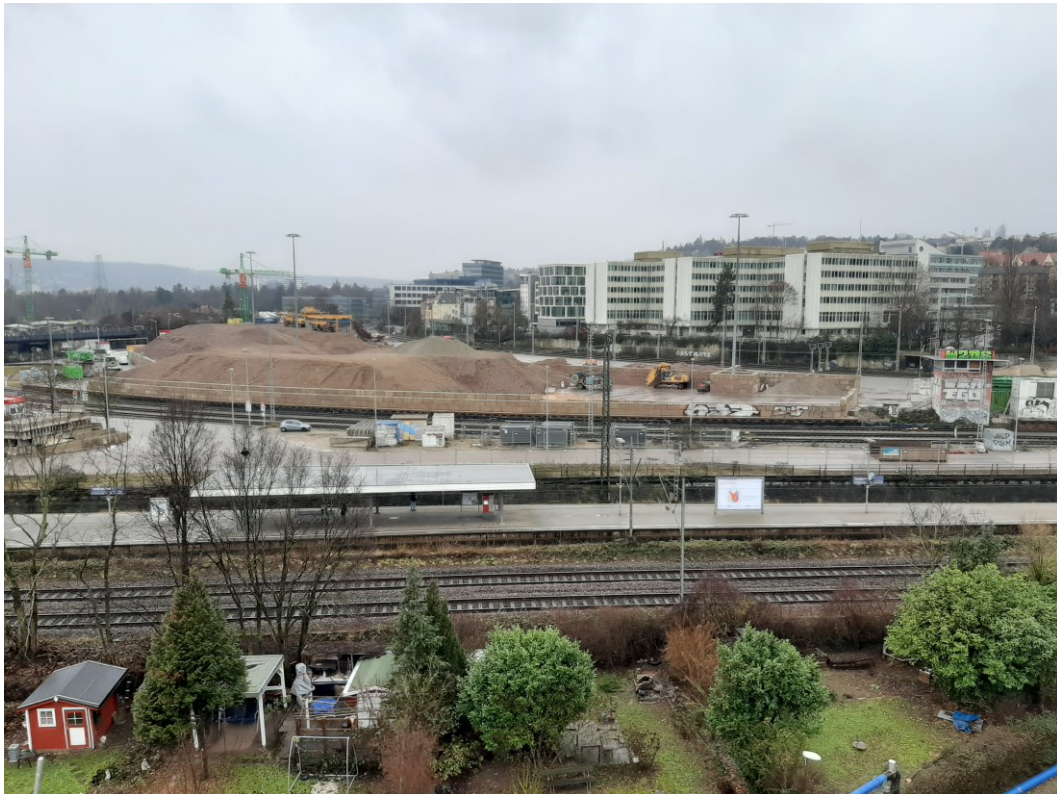
Abbildung 2: Blick auf das Baufeld bei Messende am 01.02.2021
