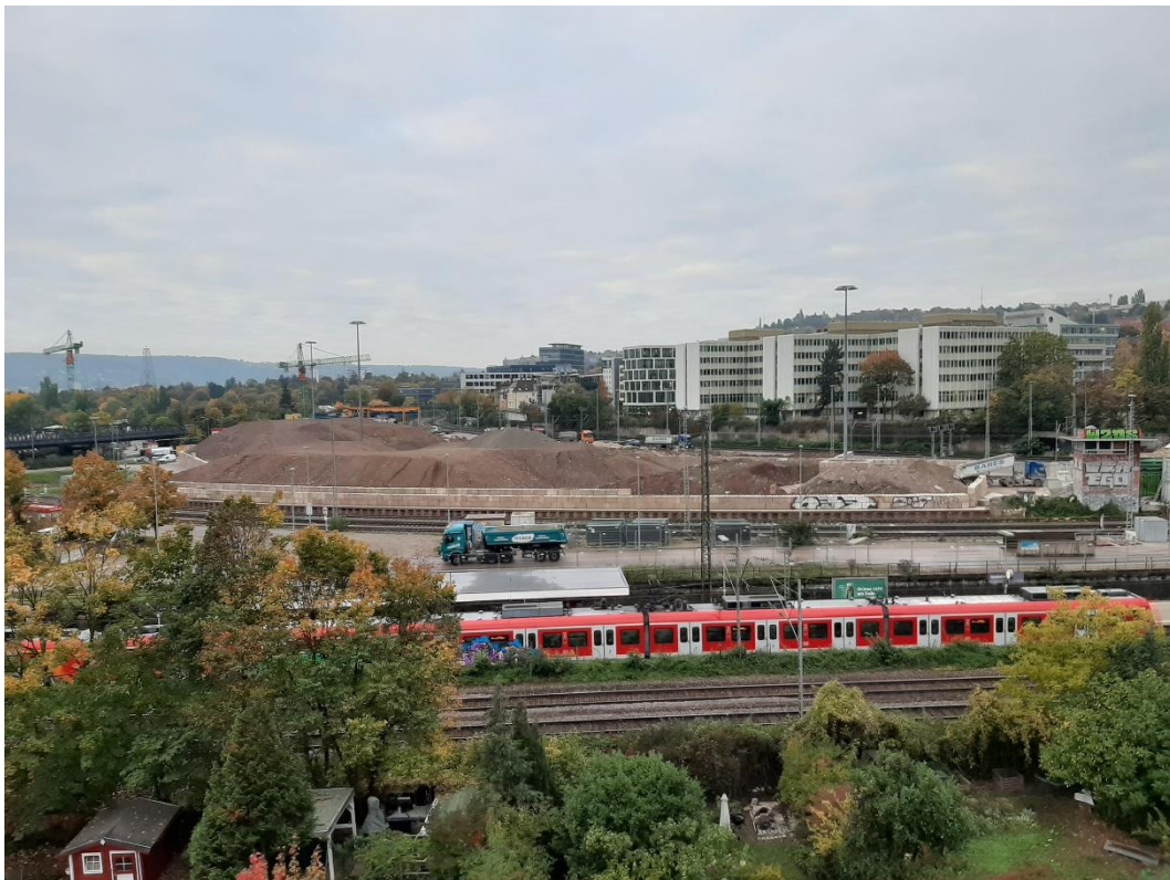
Abbildung 2: Blick auf das Baufeld bei Messende am 19.10.2020
