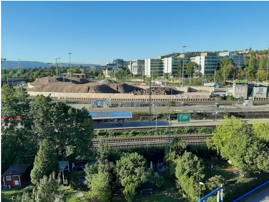
Abbildung 2: Blick auf das Baufeld bei Messende am 28.09.2020
