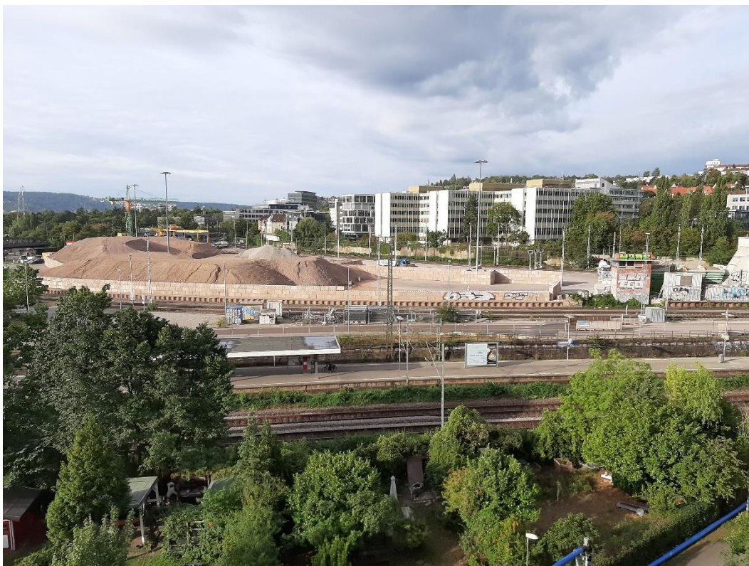
Abbildung 2: Blick auf das Baufeld bei Messende am 31.08.2020
