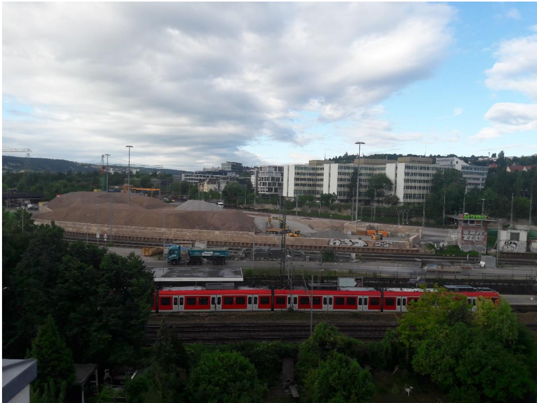
Abbildung 2: Blick auf das Baufeld bei Messende am 07.5.2020
