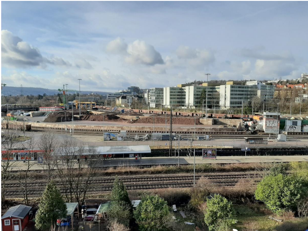
Abbildung 2: Blick auf das Baufeld bei Messende am 03.03.2020
