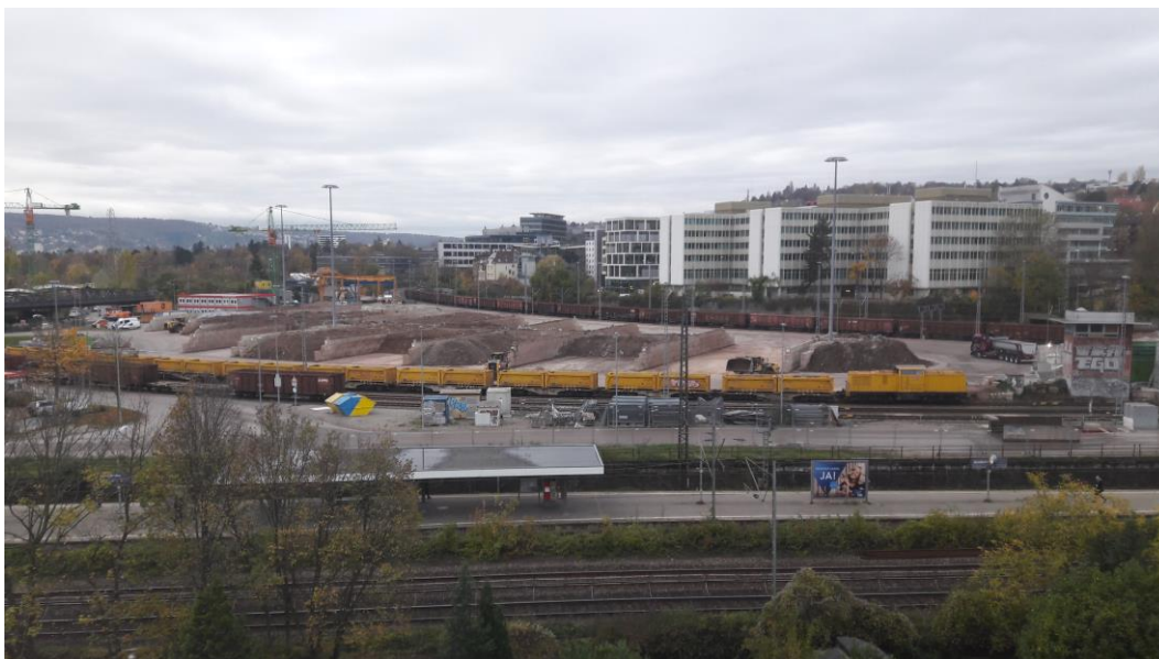
Abbildung 2: Blick auf das Baufeld bei Messende am 19.11.2019
