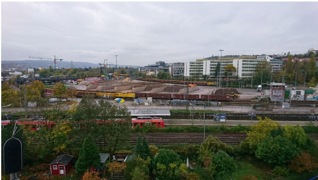
Abbildung 2: Blick auf das Baufeld bei Messende am 29.10.2019
