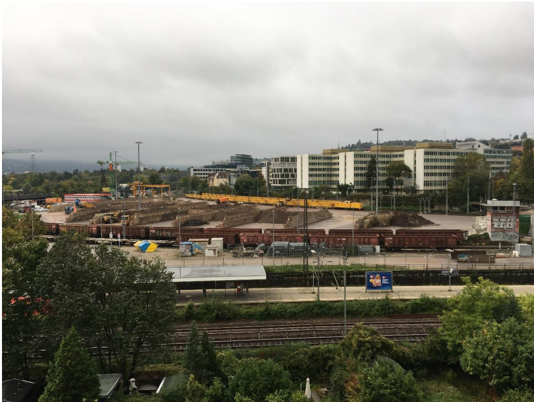
Abbildung 2: Blick auf das Baufeld bei Messende am 07.10.2019
