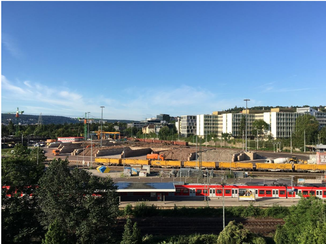
Abbildung 2: Blick auf das Baufeld bei Messende am 13.08.2019
