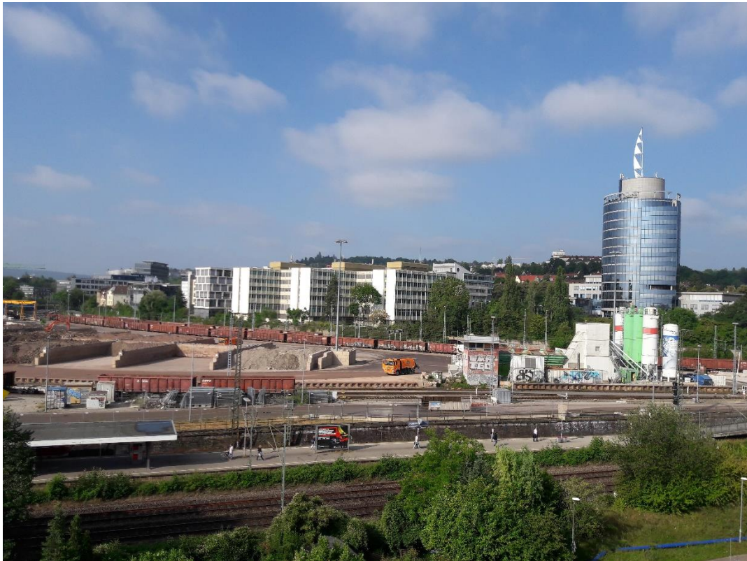
Abbildung 2: Blick auf das Baufeld bei Messende am 16.07.2019
