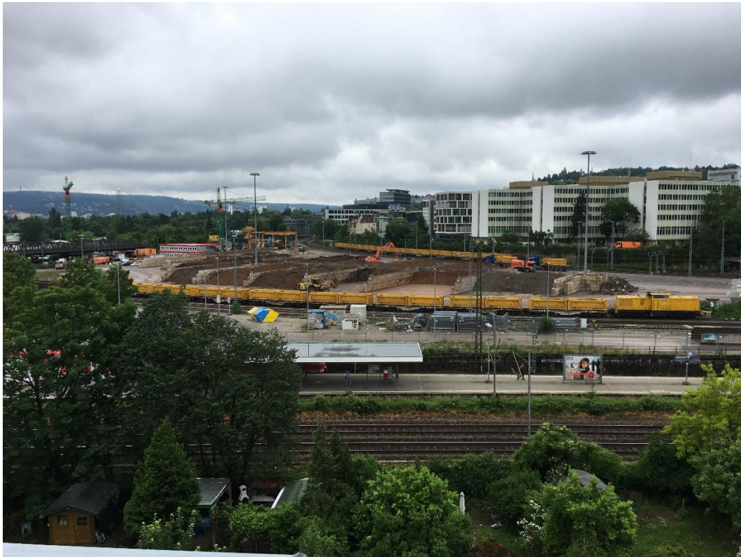
Abbildung 2: Blick auf das Baufeld bei Messende am 11.06.2019
