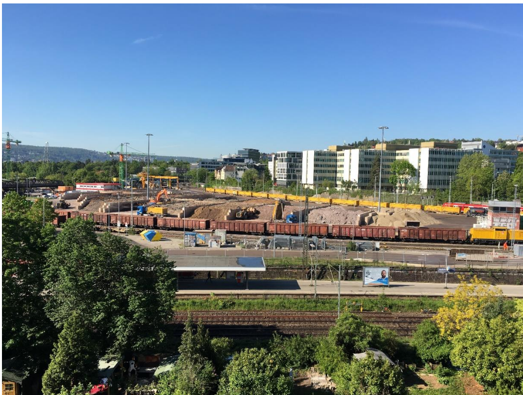
Abbildung 2: Blick auf das Baufeld bei Messende am 14.05.2019
