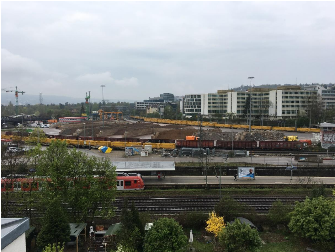
Abbildung 2: Blick auf das Baufeld bei Messende am 09.04.2019
