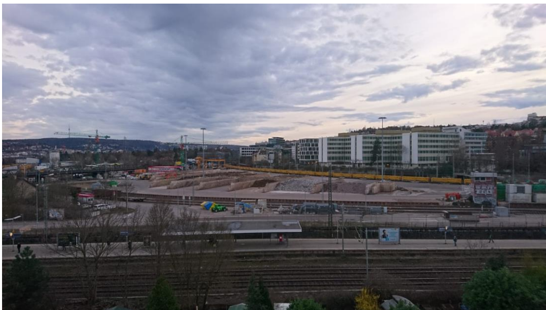
Abbildung 2: Blick auf das Baufeld bei Messende am 12.03.2019
