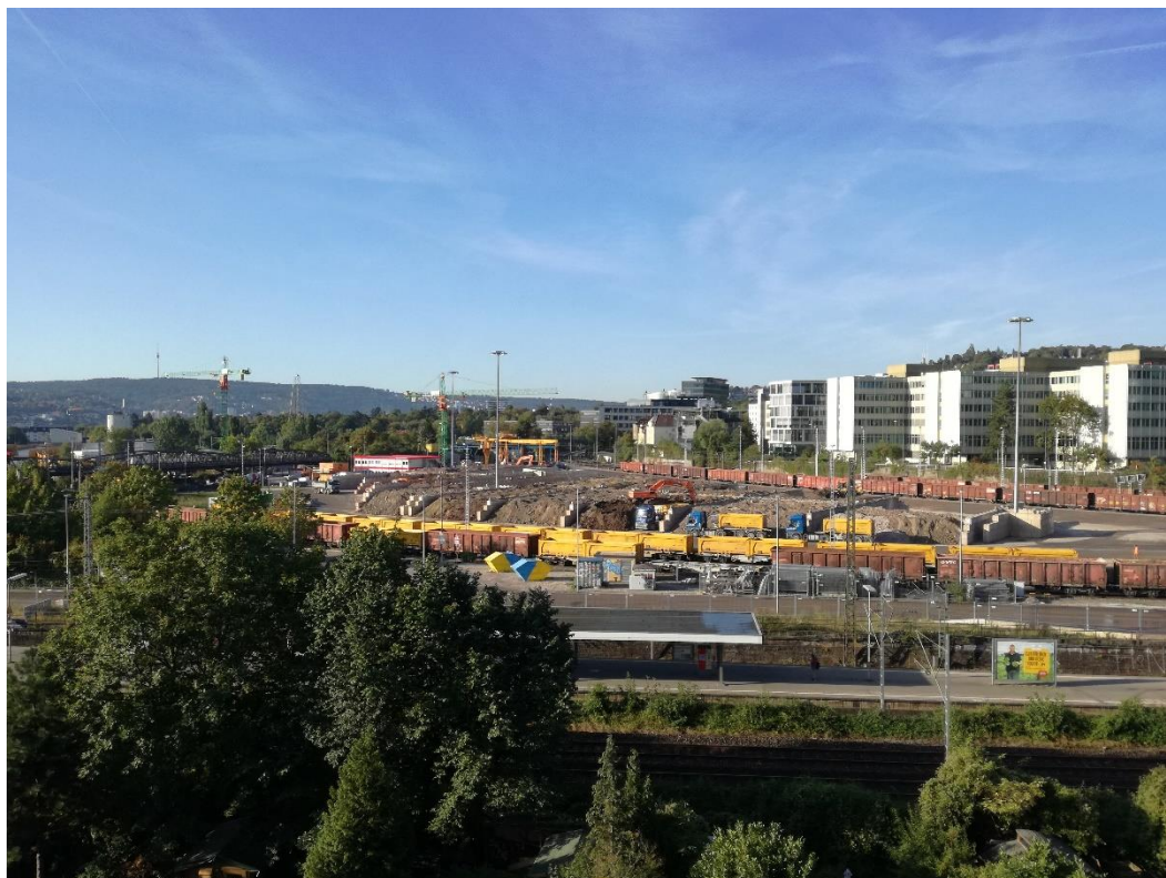
Abbildung 2: Blick auf das Baufeld bei Messende am 10.09.2018
