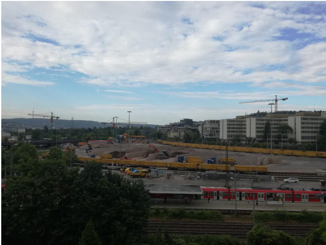
Abbildung 2: Blick auf das Baufeld bei Messende am 16.07.2018
