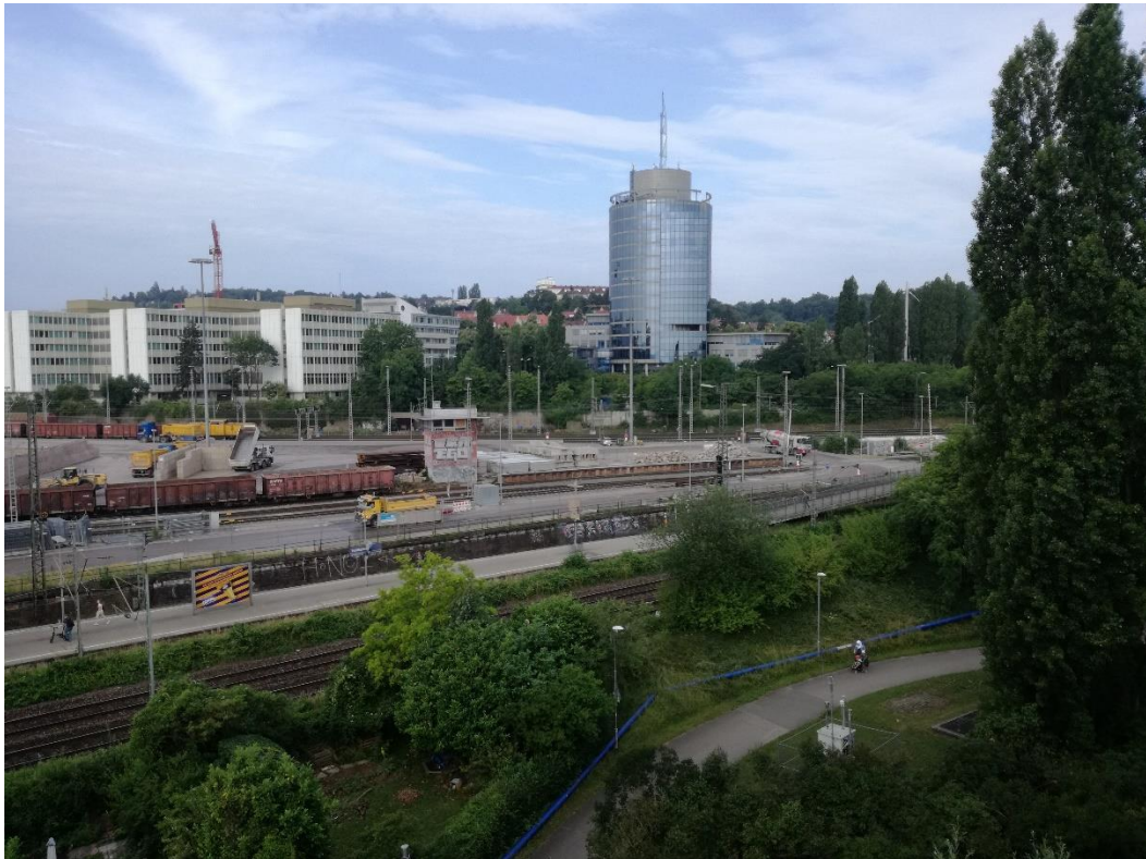
Abbildung 2: Blick auf das Baufeld bei Messende am 11.06.2018
